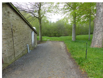
Befæstet areal ved nordgavlen af hønsehuset.
