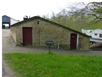
Et grundmuret hønsehus med hulmur og hårdtbrændte teglsten. Holdbart murværk med store støbejernsvinduer, som samlet set giver et stort areal i facaden.
